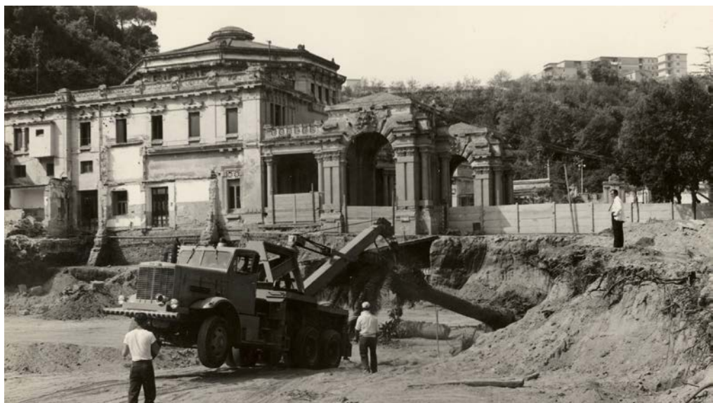
Fig.3 - I lavori di demolizione, sullo sfondo il corpo centrale dell'edificio di Arata, 1964 ca. (ASABAPN, Faldone 4/1054, n. 1, Lastra VIF_Pv30a). Su concessione del Ministero della Cultura
