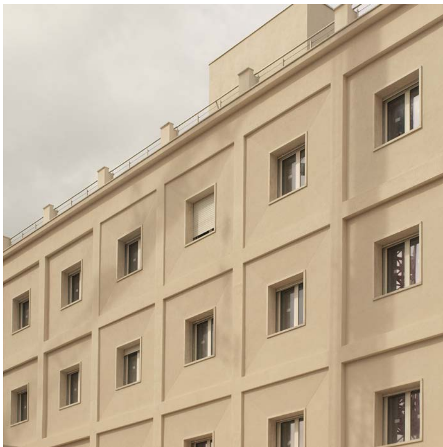
Fig.6 - Fotografia di dettaglio del prospetto principale restaurato (fotografia dell'autore, 2026)
