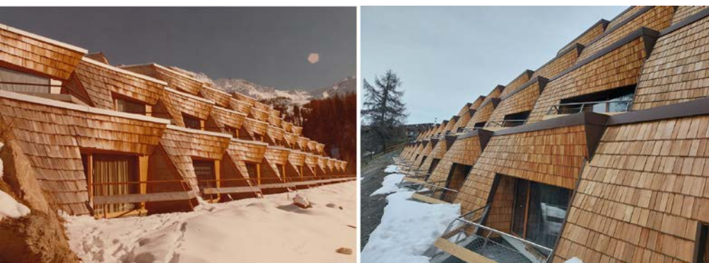
Fig.8 - Esterno del corpo residenziale G2, confronto tra la foto storica, 1978 (sulla sinistra, Fondazione MAIRE), e la facciata dopo l'intervento di riqualificazione (sulla destra, Luca Pallu, 2023)
