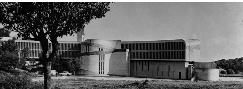
Fig.1 - Hotel Gusmay, vista da sud. Al centro il corpo curvilineo contenente il sistema delle rampe di distribuzione che collega i diversi livelli dell'edificio. Fonte: G. Aloï, Hotel Motel , Milano: Hoepli, 1970, p. 10
