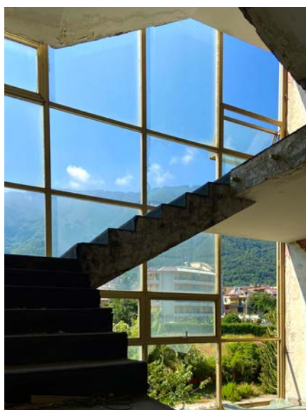
Fig.8 - Blocco scale-prospetto sud, 2025 [Castellammare di Stabia, Fotografia di Francesca Di Fusco]
