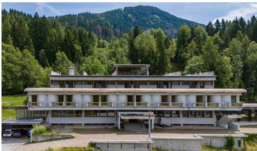
Fig.5 - Immagine dello stato attuale. Vista del fronte su strada. Fotografia di Luca Chistè / Phf Photoforma (2025)
