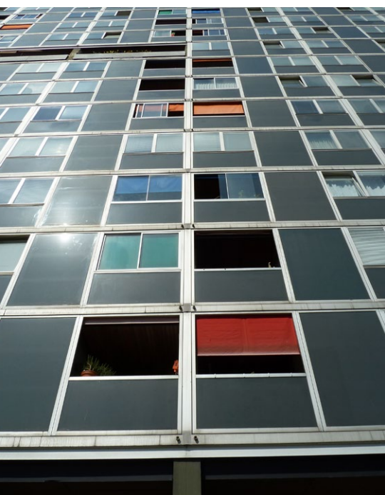
Fig.4 - Le Lignon. Particolare del curtain wall (foto di Paola Ascione)
