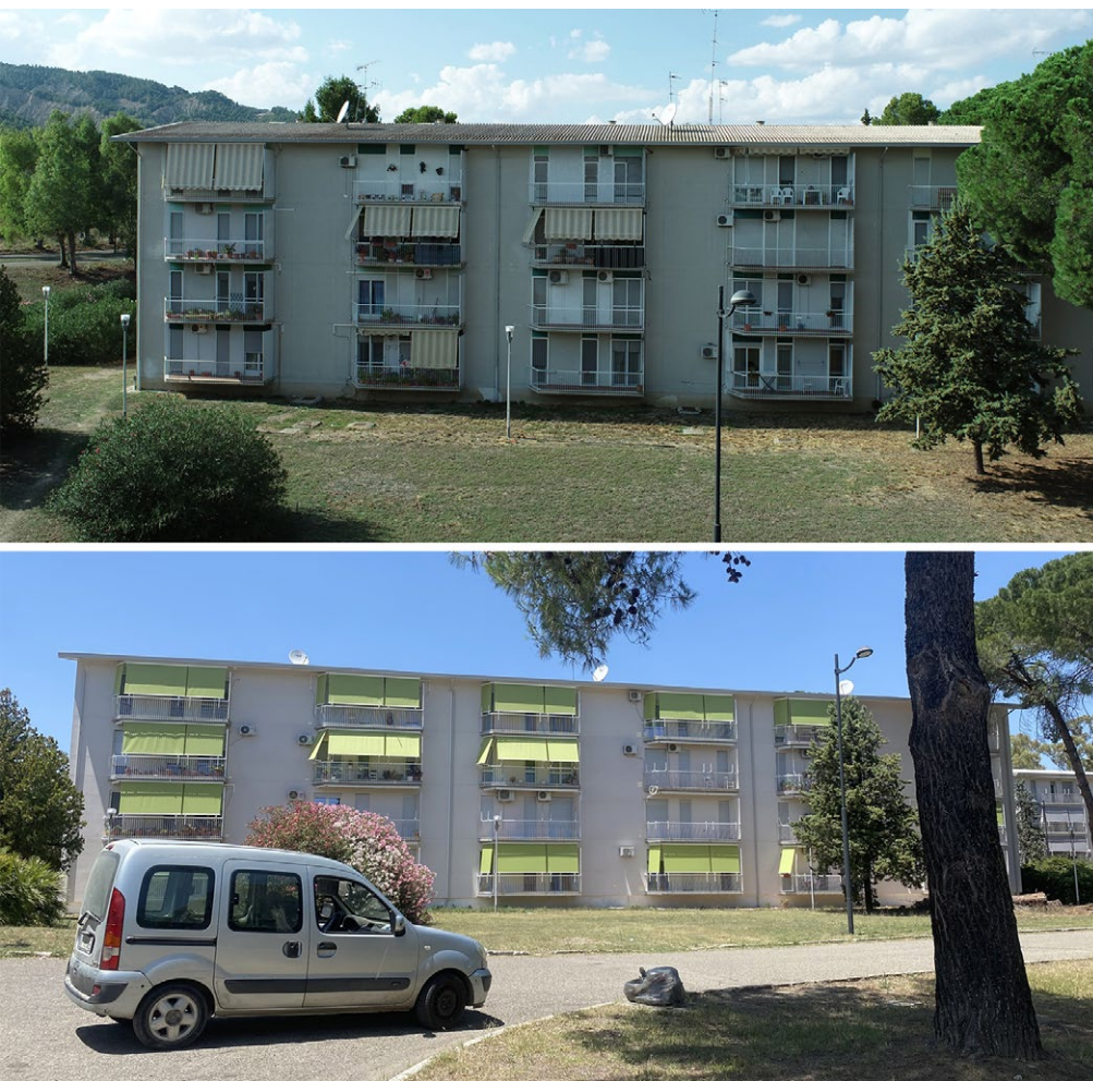
Fig.4 - Mario Bacigalupo, Ugo Ratti, edificio con attacco a terra. Intervento di riqualificazione (foto di Antonella Falotico)
