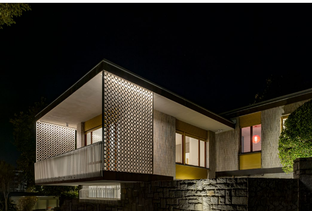
Fig.4 - La villa dopo il restauro: vista notturna della terrazza a sbalzo (foto di Paolo Mazzo)
