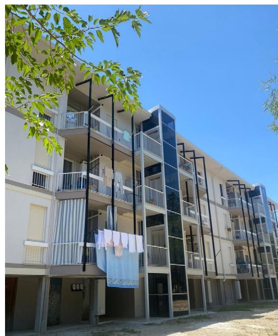
Fig.3 - Mario Bacigalupo, Ugo Ratti, edificio su pilotis con inserimento recente del blocco ascensore (foto di Antonella Falotico)
