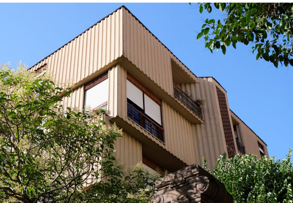
Fig.5 - Pierluigi Spadolini, edificio residenziale in via Guerrazzi 10, 1968-70, dettaglio del sistema costruttivo con pannelli prefabbricati (foto di Valentina Muscedra)
