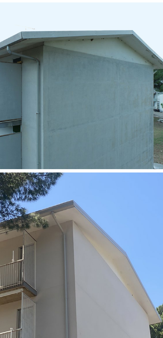
Fig.5 - Mario Bacigalupo, Ugo Ratti, edificio con attacco a terra. Dettaglio della copertura a confronto con il progetto originario (foto di Antonella Falotico)
