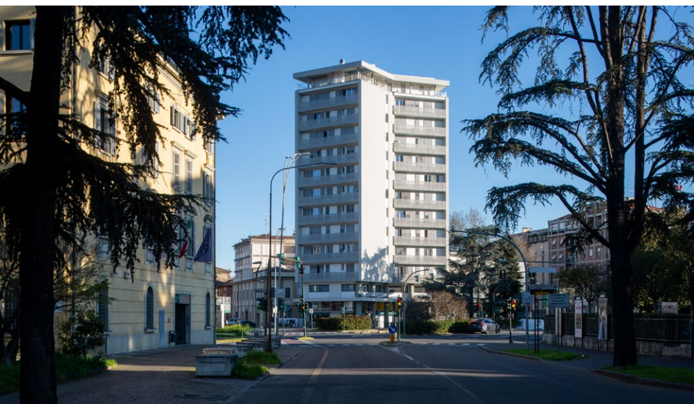
Fig.6 - Il grattacielo dopo l'intervento (foto di Kai-Uwe Schulte-Bunert)
