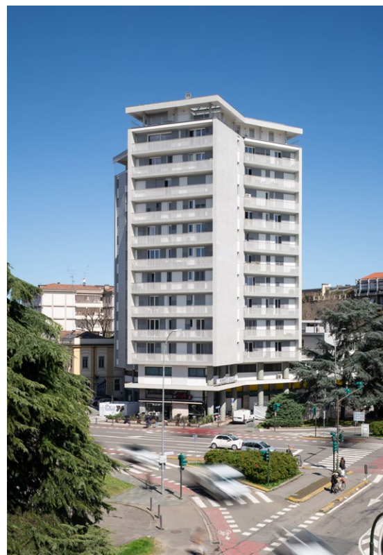
Fig.5 - Il grattacielo dopo l'intervento (foto di Kai-Uwe Schulte-Bunert)
