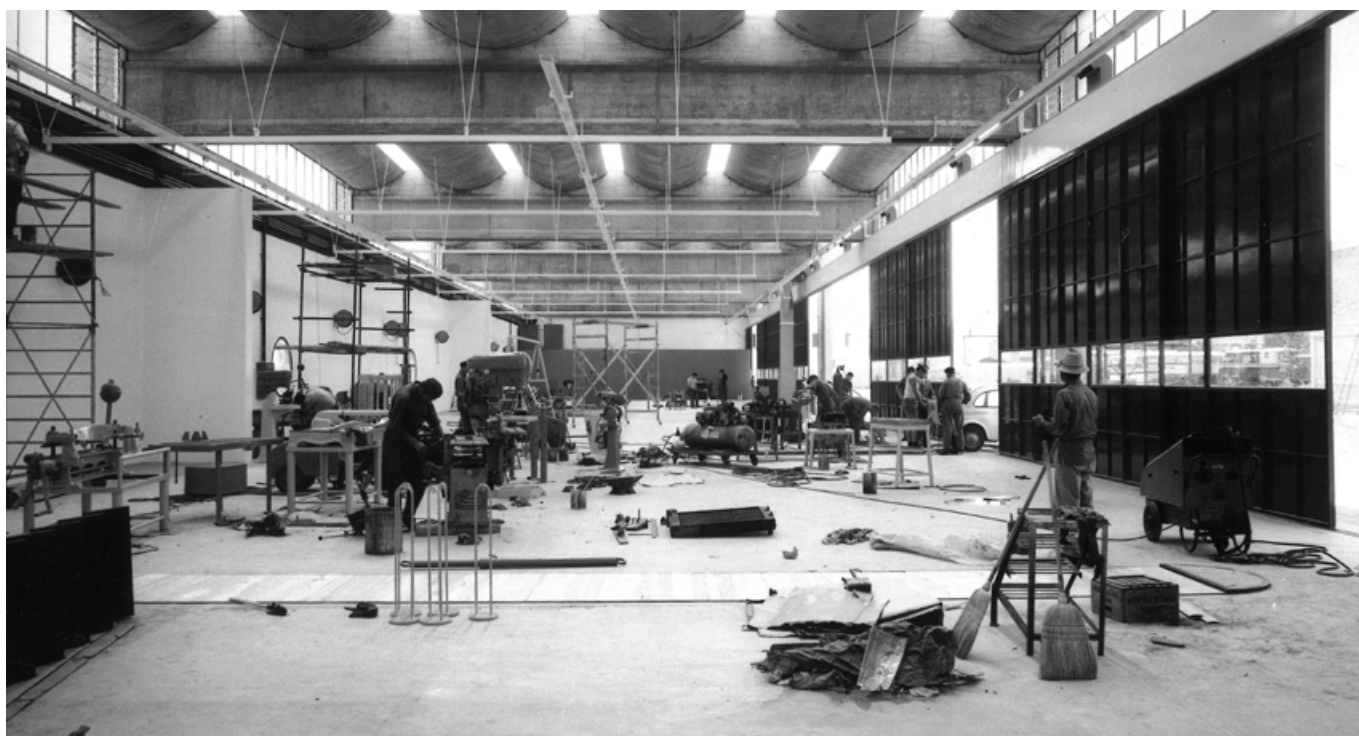
Fig.6 - Edificio per le lavorazioni pesanti: la copertura è costituita da elementi iperboloidi prefabbricati e la luce zenitale filtra da lucernari continui in poliestere a camere d'aria della SAMP (Archivio Architetto Glauco Gresleri)
