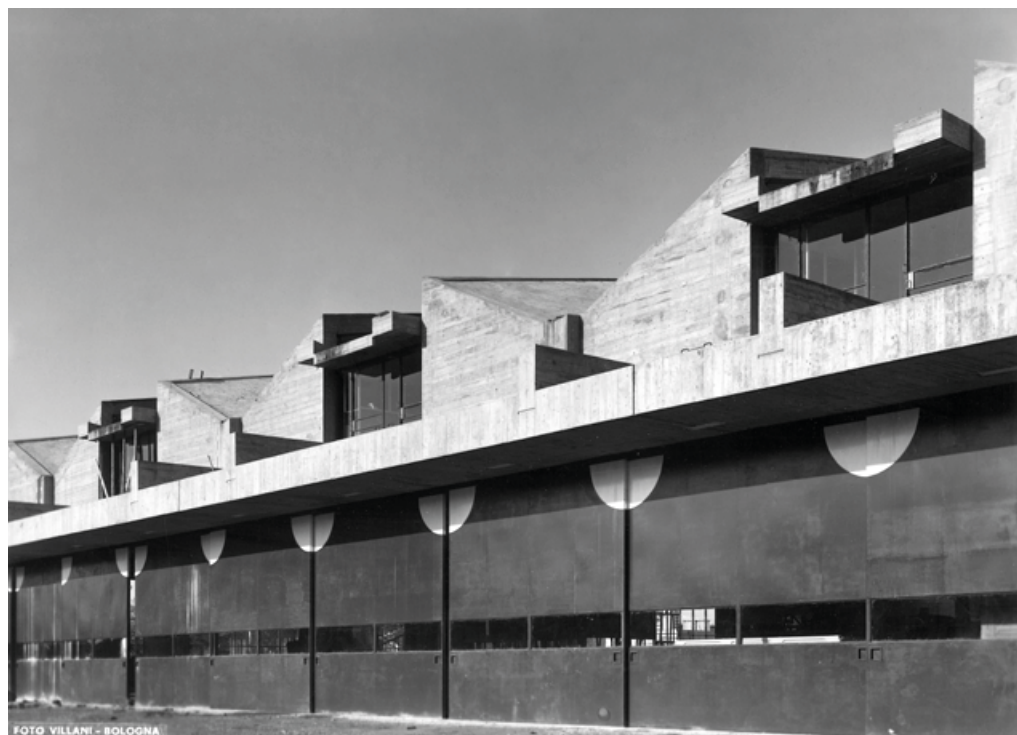
Fig.4 - Fianco est del corpo centrale del complesso. Le solette piane appese tra le travi contigue di copertura sporgono in aggetto con i 'boccacci' per lo scarico dell'acqua a pelo libero (Archivio Architetto Glauco Gresleri)
