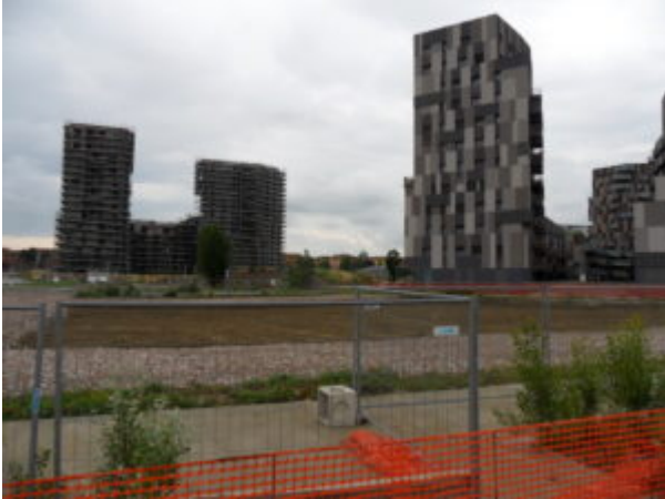
Area di trasformazione Navile - stato attuale con gli edifici incompiuti e le aree pubbliche in abbandono (©Luca Gulli)
