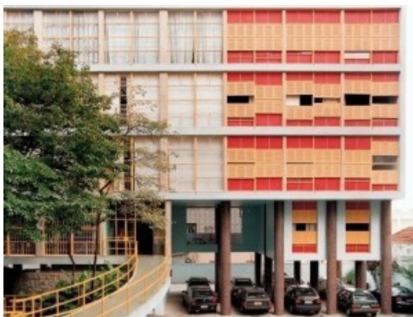
Edificio Louveira a San Paolo del Brasile, 1973
